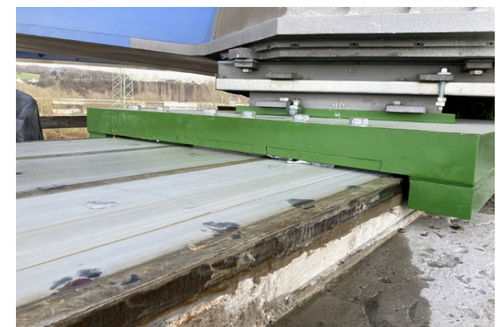
Auf den 3100 Millimeter breiten und 20 Meter langen Verschubbahnen aus Stahl glitten die Schlitten in die gewünschte Position.
