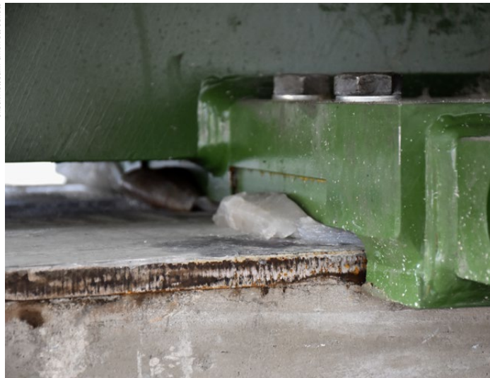
Für eine reibungsarme Verschiebung wurde der Schlitten durchgehend mit einem teflonhaltigen Fettfilm geschmiert.
