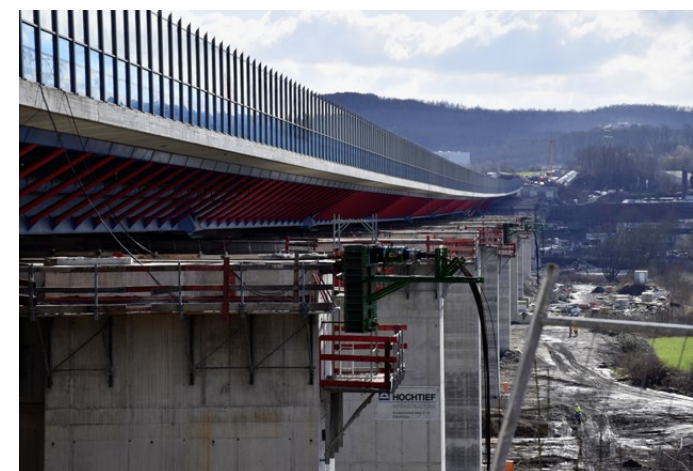
Der Überbau war auf temporären Pfeilern neben der Autobahn errichtet worden, die nach der Fertigstellung wieder abgerissen wurden.
