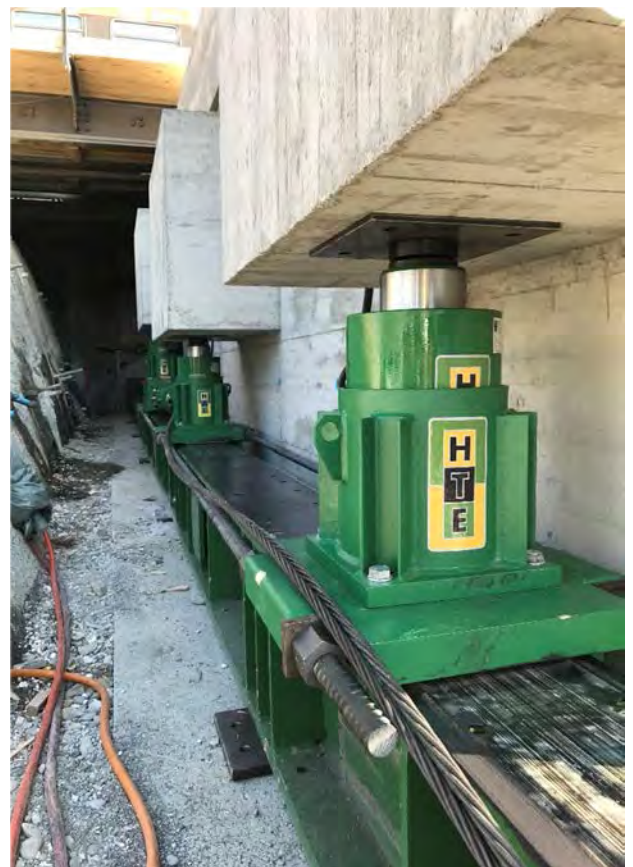
Verschubkonstruktion (Verschubbahn, Schlitten und Hydraulikpressen) mit angehobener Last während des Verschubes.
