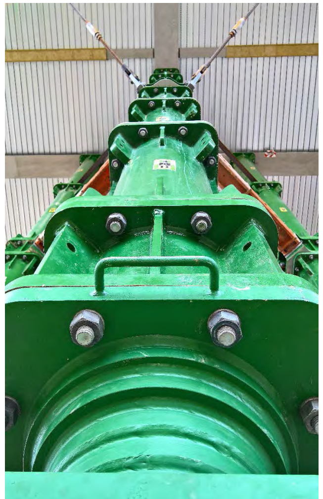
Vue d'ensemble d'un des 4 poteaux constitutifs d'une des 19 tours de levage en situation finale.
