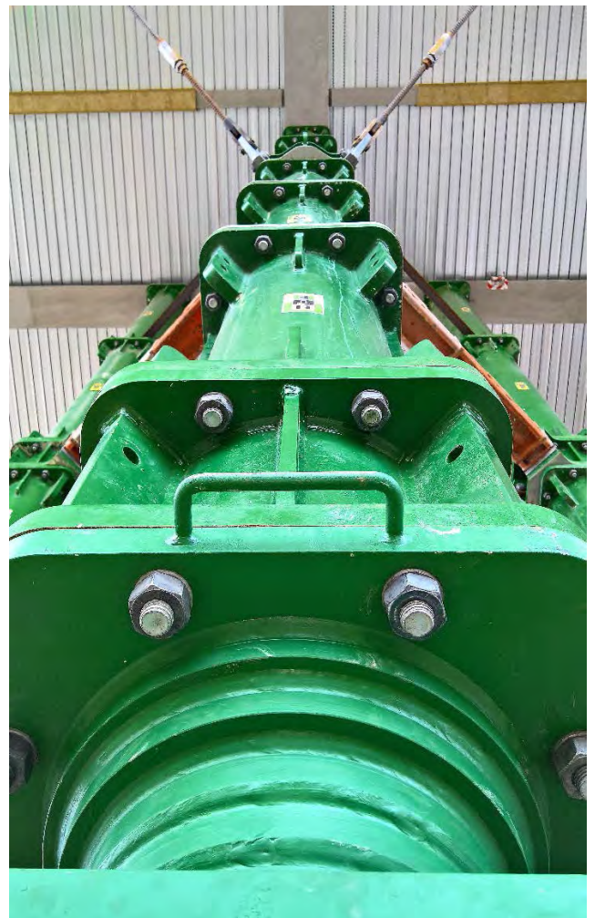
Eine von vier Stützen der insgesamt 19 Hubtürme in finaler Hubhöhe.
